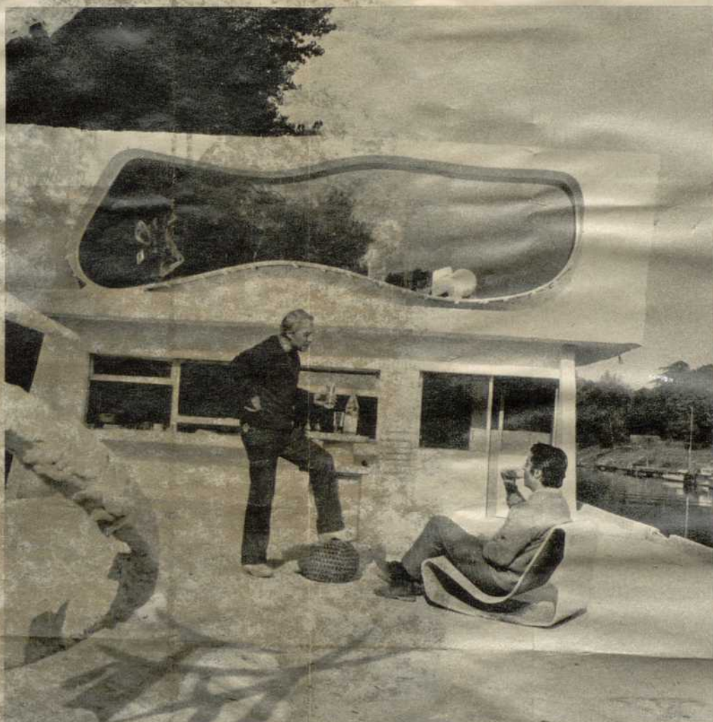
SUR UNE PÉNICHE, SAINT-MAUR A « SCULPTÉ » SA DEMEURE EN MOUSSE DE POLYURÉTHANE. Un matériau-miracle qui permet toutes les audaces de formes pour un prix modique.
