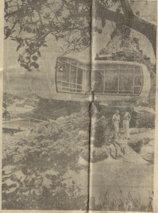
La « Maison de l'Avenir », en matières plastiques, est le résultat heureux des recherches du Massachusetts Institute of Technology, et en particulier l'ingénieur Dietz. Elle est actuellement installée à Disney Land.
