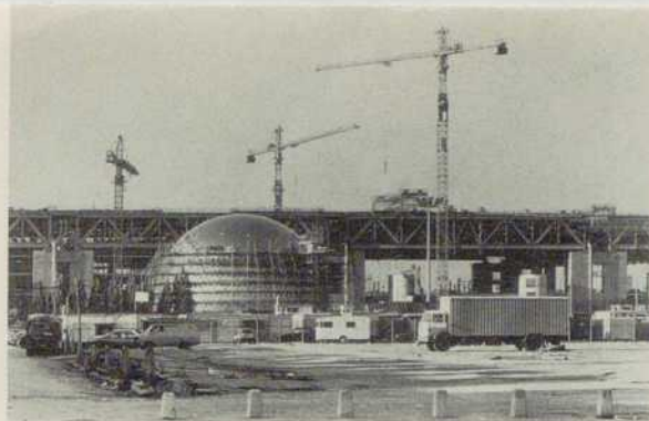
Chantier Biennale de Paris
